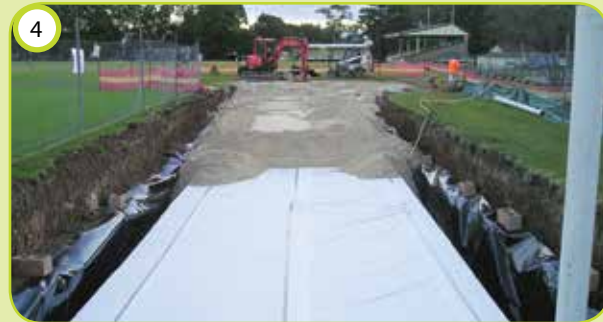
4 Plaats geotextiel en vul aan met zand
