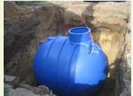
Gebruik van regenwater met kunststof tank.
