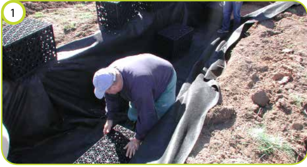
1 Plaats de boxen in het geotextiel
