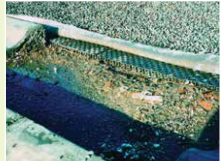
Infiltratie en buffering onder de bestrating.
