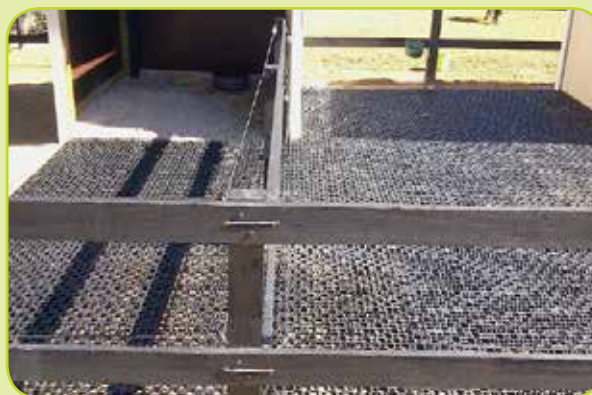
1 Plaats drainageplaten in dressuurbak
