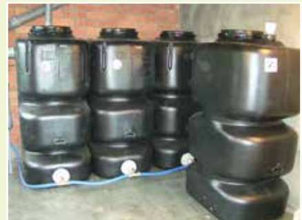
Regenwatertanks in een kelder.
