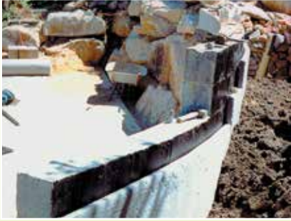
Verticale drainageplaten voorkomen vochtproblemen bij kelders en muren.
