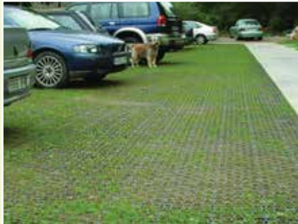
Waterdoorlatende parkeerplaatsen met grastegels.
