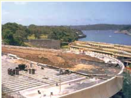
Drainageplaten maken grote daktuinen, zelfs met zware belasting, mogelijk.
