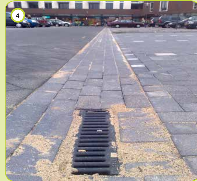
4 De bestrating wordt boven de drainage platen geplaatst met daarbij de benodigde afvoergoten die infiltreren in de GEP drainage platen
