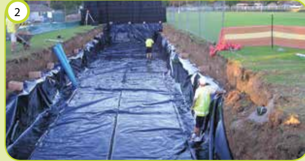
2 Plaats het waterdichte folie
