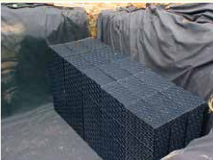
Met de GEP Matrix Boxen worden eenvoudig grote infiltrerende waterbuffers gebouwd.
