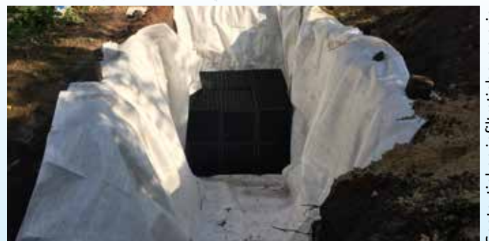
Geotextiel en infiltratieboxen erin
