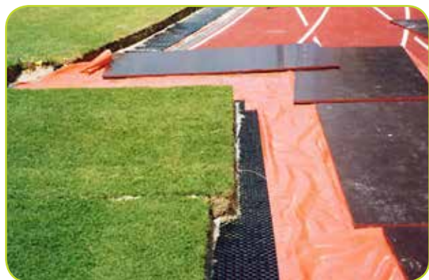
1 Plaats drainageplaten op folie
