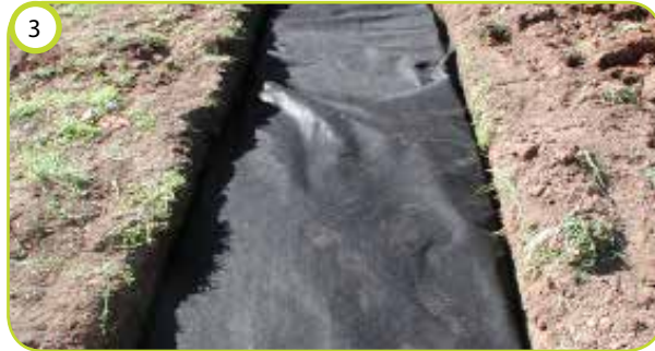
3 Geotextiel terug gevouwen
