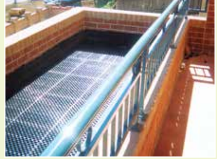
Drainageplaten vormen een isolerende basis voor elke daktuin en plantenbak.
