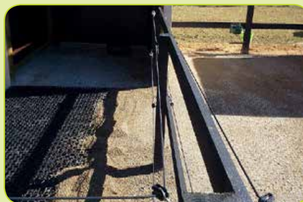
3 Leg het zand over de drainageplaten
