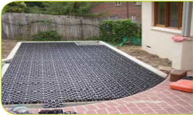
1 Waterdoorlatende "bestrating" met grastegels
