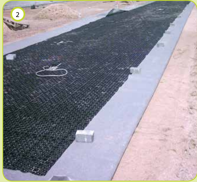
2 De GEP 52 mm drainage platen worden op het geotextiel gelegd
