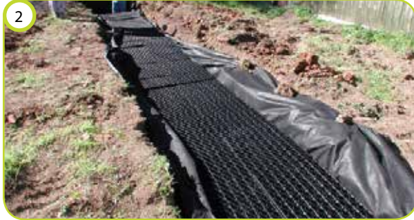
2 Vouw het geotextiel terug
