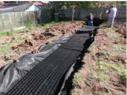
Infiltratievoorziening in een tuin.
