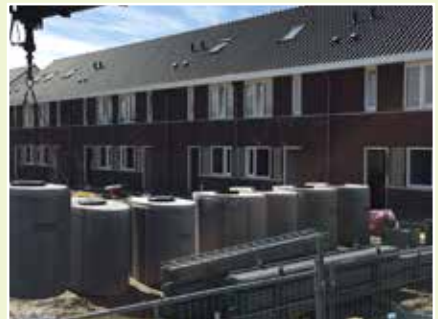
Regenwaterputten bij grootschalige woningbouw met regenwatergebruik.
