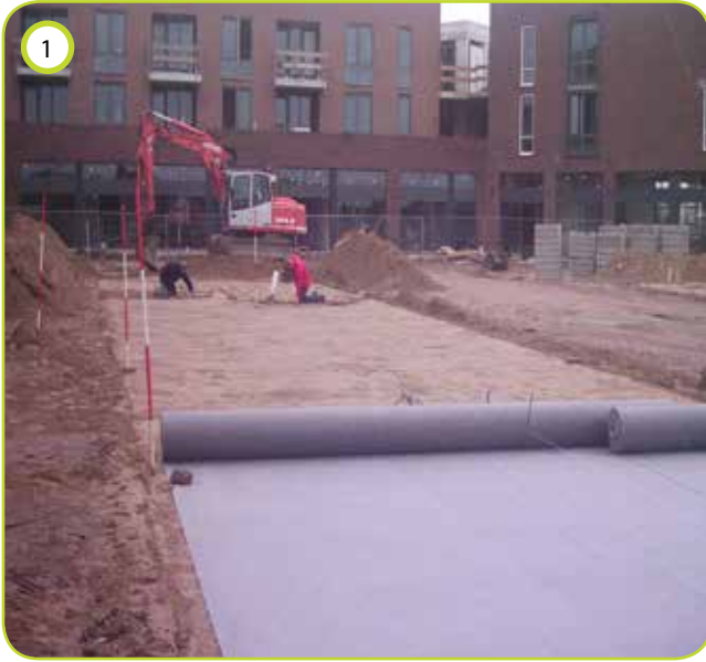
1 GEP geotextiel wordt geplaatst
