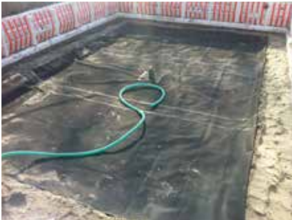
Waterzak als regenwatertank in kruipruimte.
