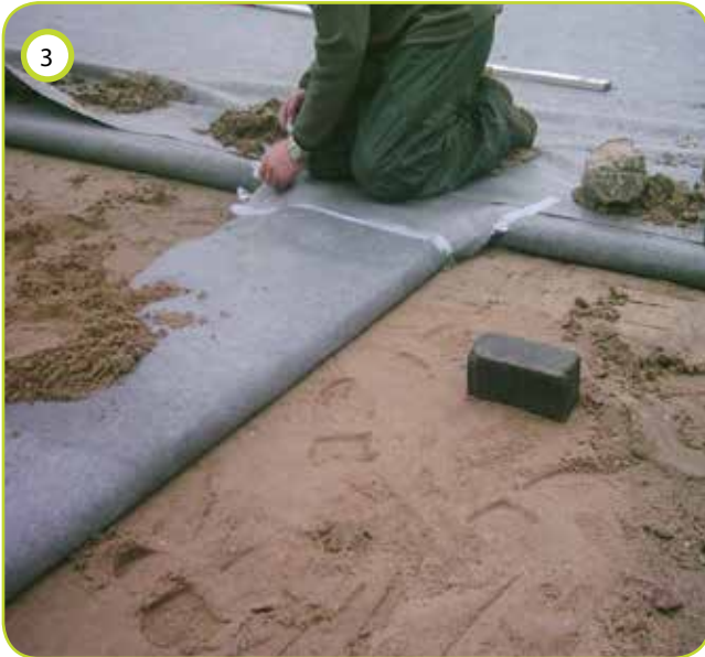
3 De GEP 52 mm drainage platen worden omwikkeld in geotextiel
