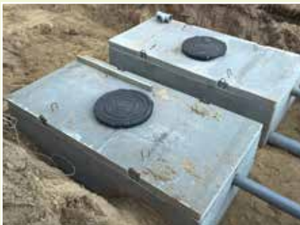
Infiltratiebakken van beton
